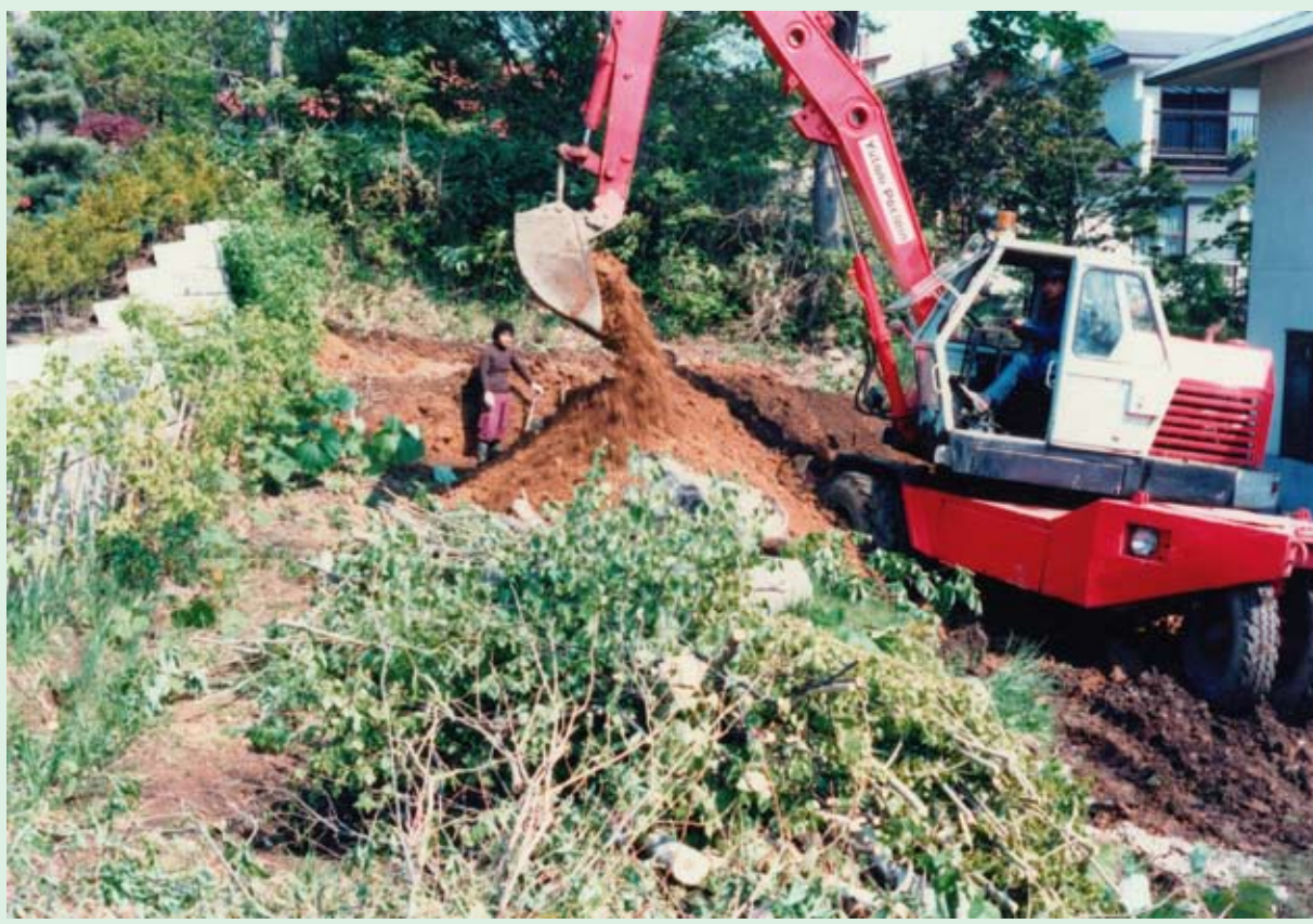
駐車場の整備工事（1981年5月） 本郷新記念館の庭の一部を整備し、10台分の駐車スペースを確保
